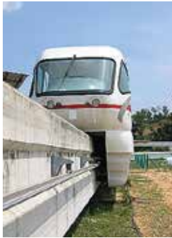
Under running mono rail system (Kuala Lumpur)
